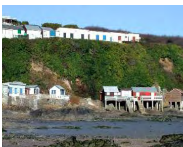
Construit illégalement sur le domaine littoral (zone NDI), les cabanons de la "cité Baby" (plage du Valais) et la "cité Monaco" (plage de St Laurent) dispose que partiellement de système d'assainissement.
