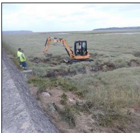
Fig 17 : Curage clapets antimarée à Languieux
