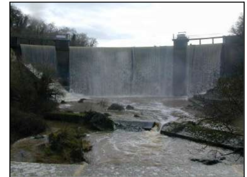
Fig 19 : Barrage de Pont-Rolland
