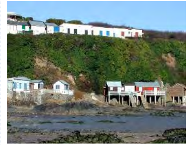
Construit illégalement sur le domaine littoral (zone NDI), les cabanons de la "cité Baby" (plage du Valais) et la "cité Monaco" (plage de St Laurent) dispose que partiellement de système d'assainissement.
