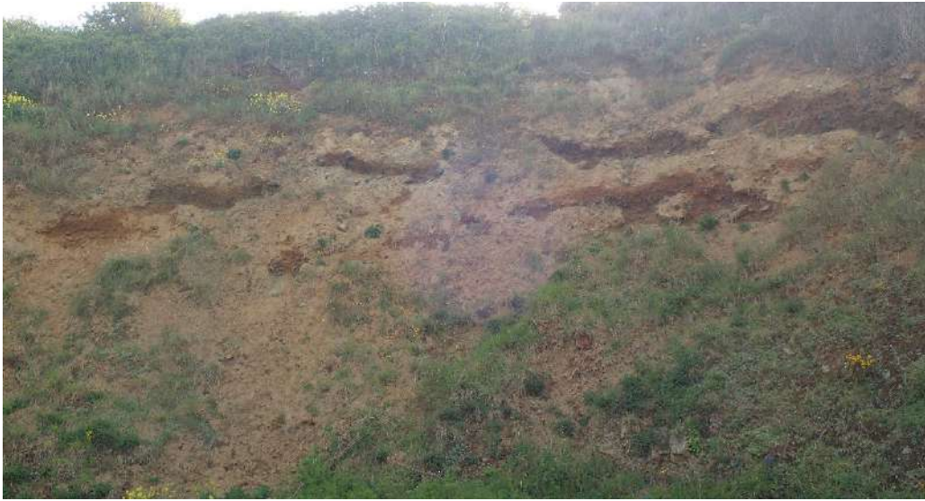
Figure 13 : Site de Kersaint, mise à jour des galeries après effondrement. @V.Jego
