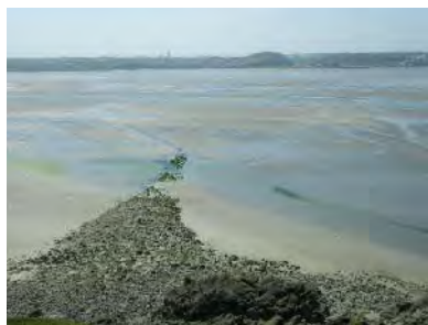
Fig.- 13 Reste des empierrements réalisés en 1767.
